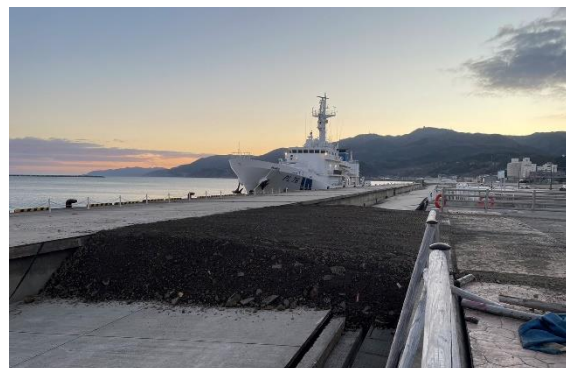
応急復旧後の状況（水深7.5m岸壁）
