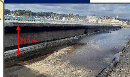
岸壁背後の沈下
