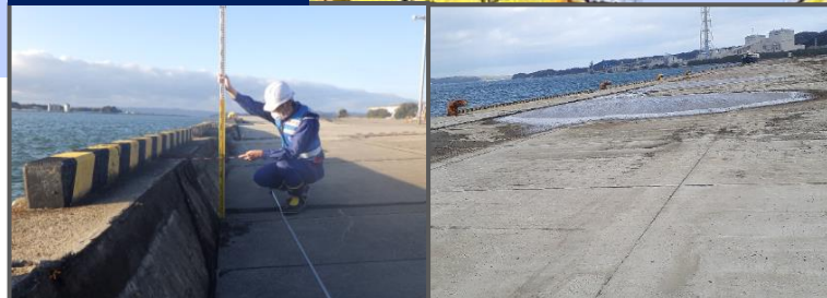
岸壁の沈下
