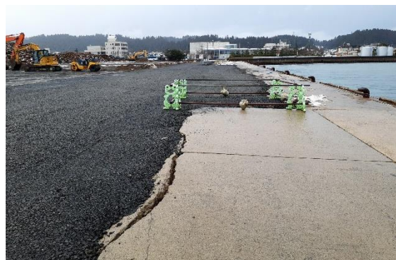
応急復旧後の状況（水深4.5m岸壁）
