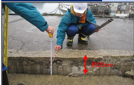
岸壁背後の沈下
