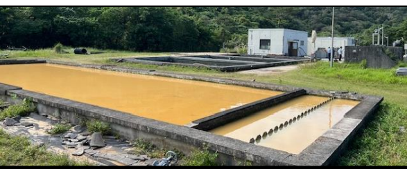
津波浄水場被災箇所(濾過池への土砂流入)
