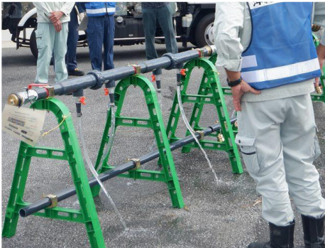
応急給水栓組み立て、洗浄操作確認
