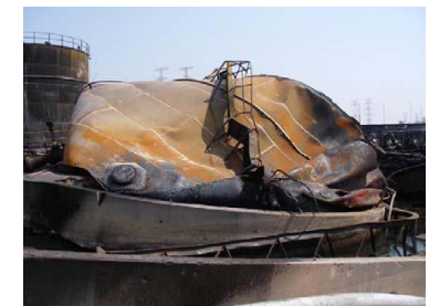
(写真)焼損したガソリンタンク※2
