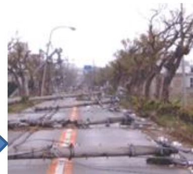
台風による電柱倒壊
