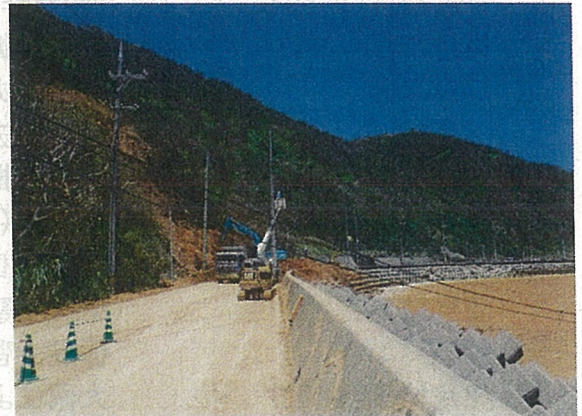
土砂撤去状況(H27.7.31時点)
