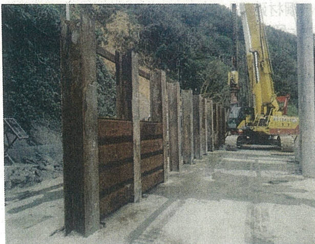
仮設土留工—H鋼材建込状況(H27.9.16時点)
