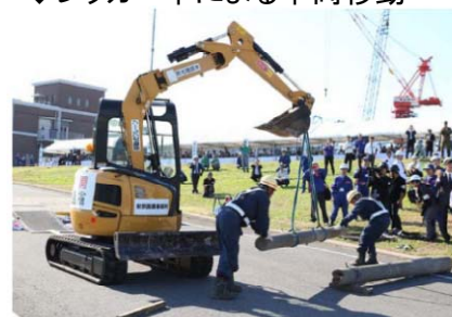
◆倒壊電柱を除去
