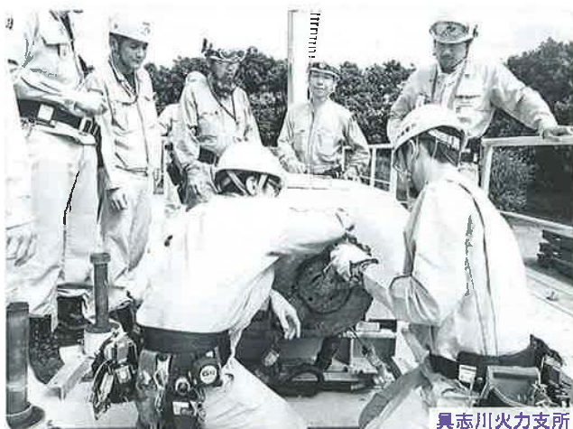
ロータリースクリーンシャーピン取替訓練
