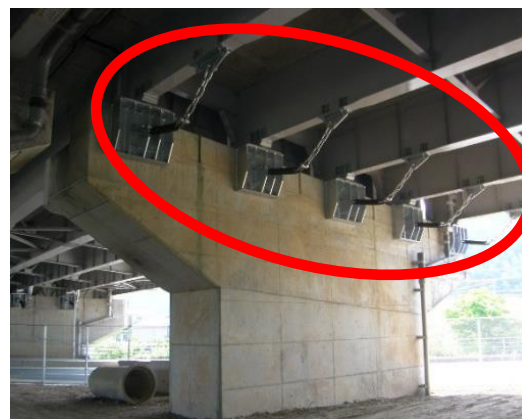
【落橋防止構造】
