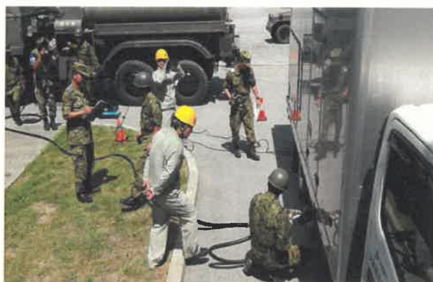
※自衛隊タンクローリーによる電源車への給油風景 （自衛隊那覇訓練場）
