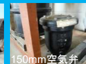
150mm口径の空気弁
