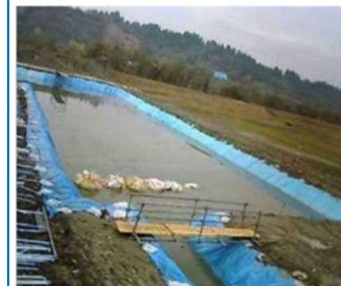
仮設沈殿池の設置例
