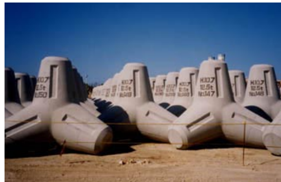
生物の着生促進を旨とした消波ブロックの一例 (平良港湾工事事務所、撮影平成10年)
