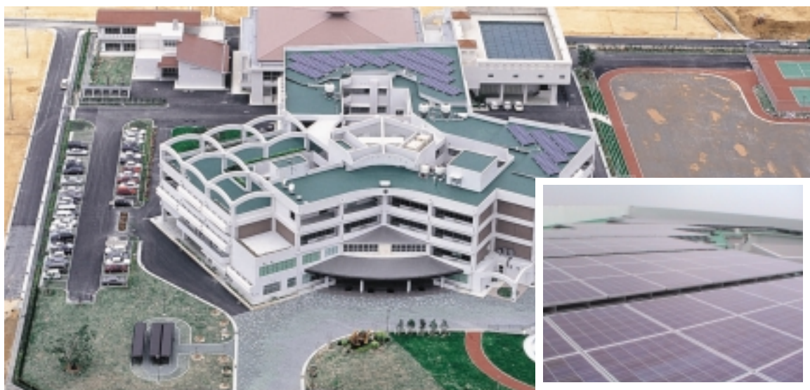
沖縄県立那覇国際高等学校の太陽光発電設備[50kW]
