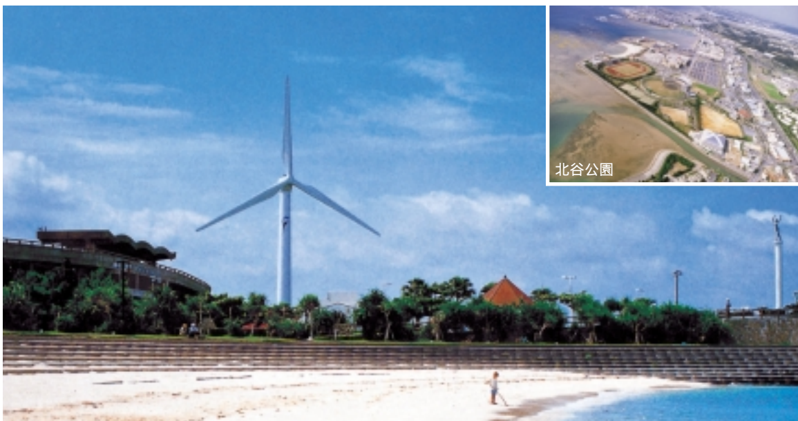
北谷町風力発電施設(490kW)
