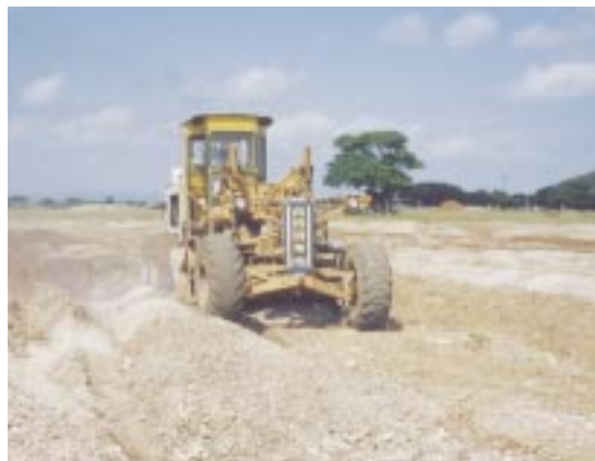
スタビライザーによる採草放牧地の造成
