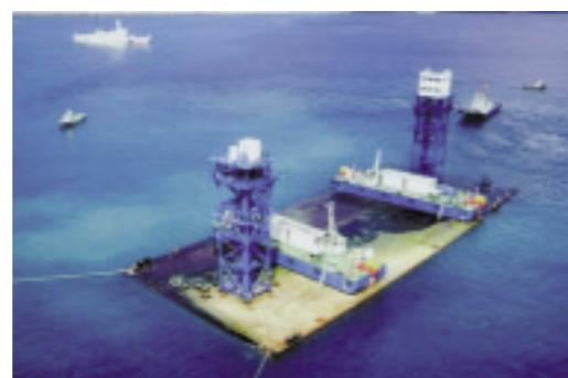
写真4 同日正午の唐口(とうぐち)航路で三重城側立坑より1号函を引き込む。
