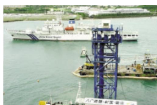
写真7 九月三十日(日)沈設・接合時に機器が正常に作動するか接合部分により三重城側立坑を近づけシステムのチェックを行う。
