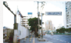
那覇地区電線供給共同溝
