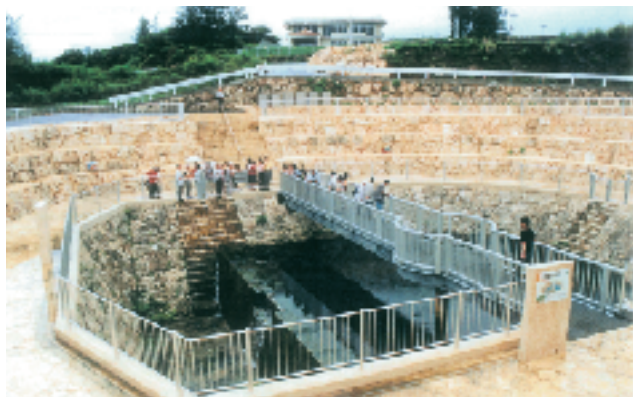
福里地下ダム水位水質監視施設
