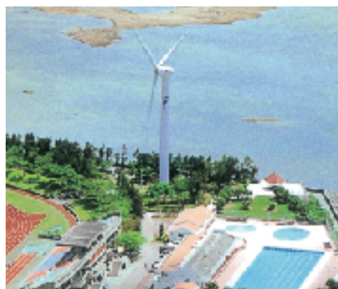
風力発電設備
