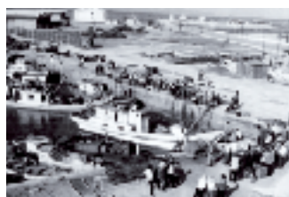
復帰当時の石垣港離島棧橋
