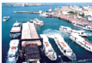
現在の石垣港離島棧橋
