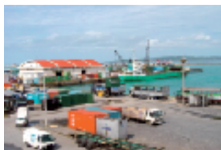
現在の平良港の荷役の様子
