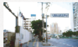
那覇地区電線供給共同溝
