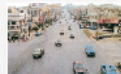
国道330号沖縄市胡屋付近
