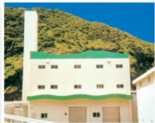
財政融資資金を活用して建設された施設。
