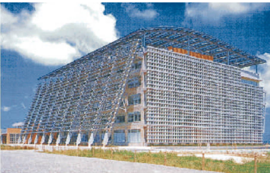
糸満市役所新庁舎太陽光発電システム：[平成14年度第7回新エネ大賞（資源エネルギー庁長官賞）を受賞]容量195.6kw
