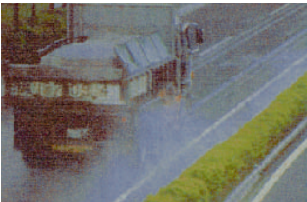
雨天時の通常舗装
