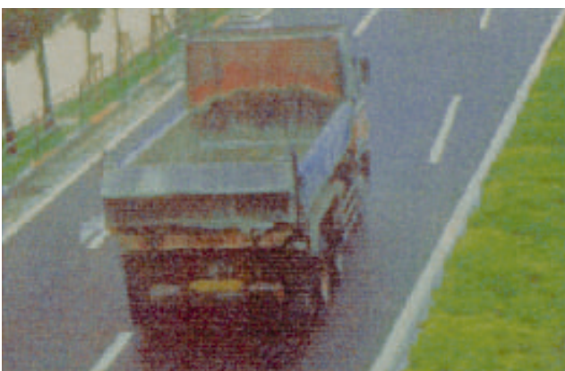
雨天時の低騒音舗装
