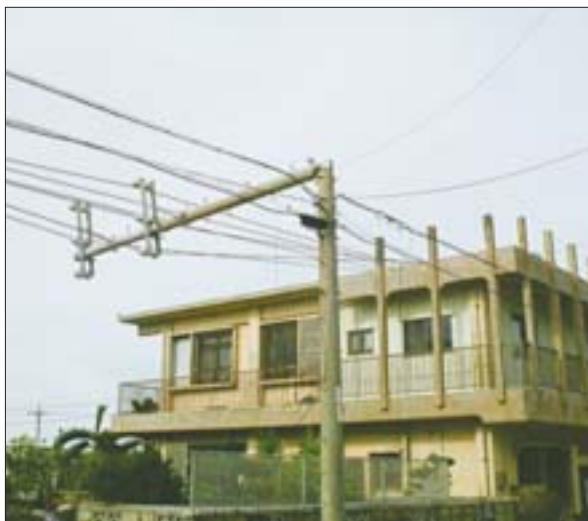
電柱の折損
