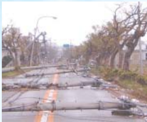
台風14号による電柱の倒壊(宮古島)
