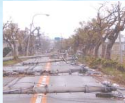
台風14号による電柱の倒壊(宮古島)
