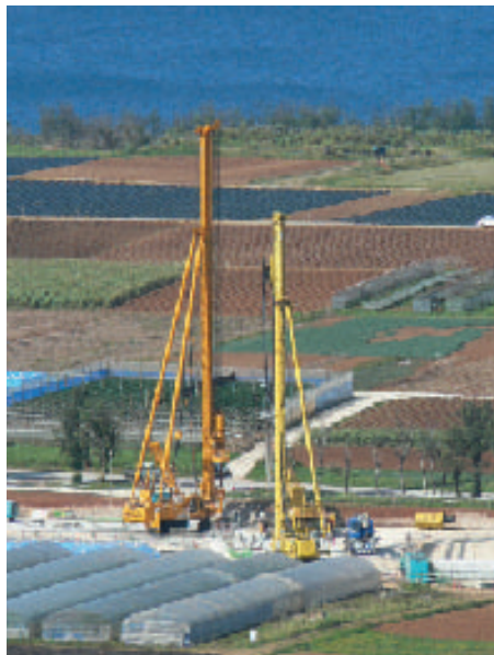
伊江地下ダム工事
