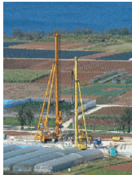
伊江地下ダム工事
