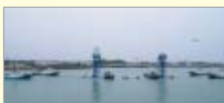
3. 6号函曳航状況(平成19年5月19日撮影)
