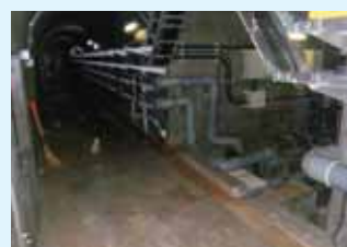
羽地ダム監査廊
