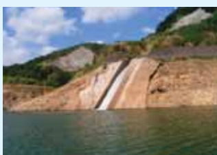
調整水路注水口（出口）
