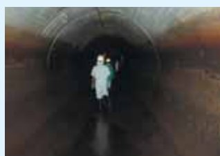
調整水路内部
