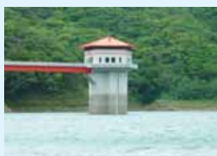
羽地ダム取水塔
