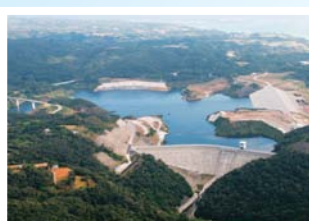
大保ダム全景
