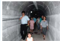
ダムの中(監査廊)に進入!
