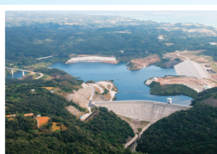
大保ダム全景
