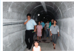
ダムの中(監査廊)に進入!
