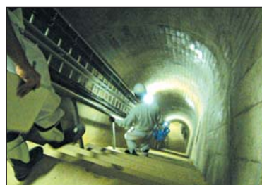
ダム本体内（監査廊）状況
