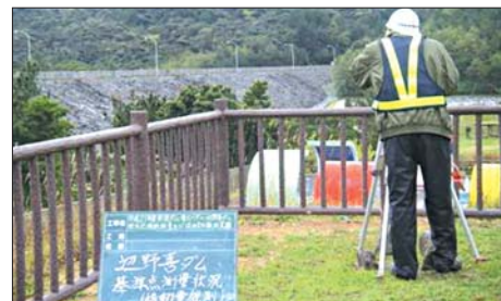
地震発生時にも緊急的に堤体観測を実施します。
