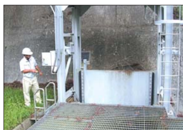
調整水路の送水ゲート点検（辺野喜ダム）
