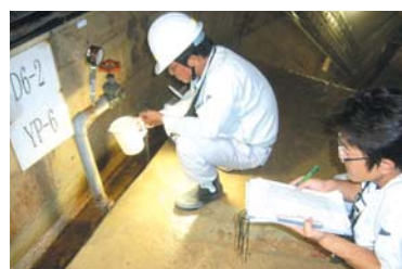
漏水量観測箇所は何十箇所もあります。
