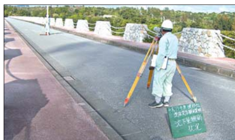
ダム天端の変位確認
