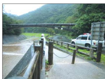
下流の安全の為、大雨時には巡視を行います。
