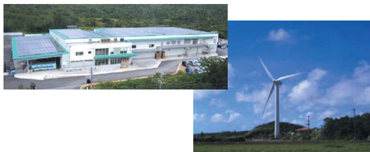
■太陽光パネルを屋上に設置した総合農産加工施設（東村、左上） 風力発電施設（宮古島市、右下）
