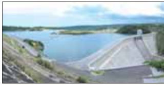
大保ダム (H23供用予定)
