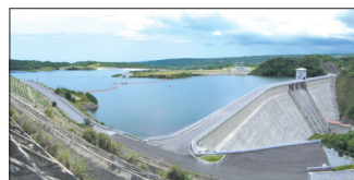
大保ダム(H23供用予定)
