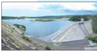
大保ダム(H23供用予定)
