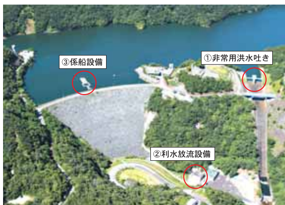
■福地ダムの例（代表的な設備）
