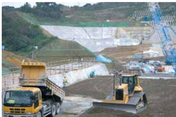
写真-4 CSG状況打設
