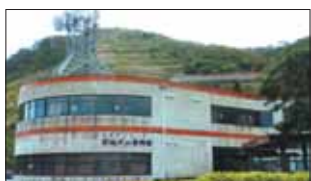
羽地ダム地域防災センター
