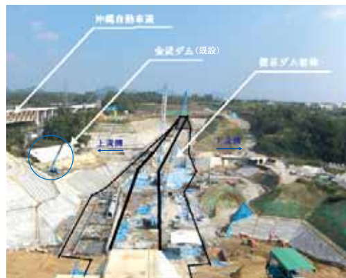
写真-3 億首ダム工事状況（全景）
