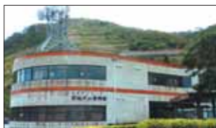
羽地ダム地域防災センター
