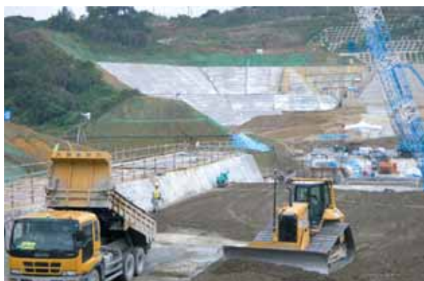
写真-4 CSG状況打設
