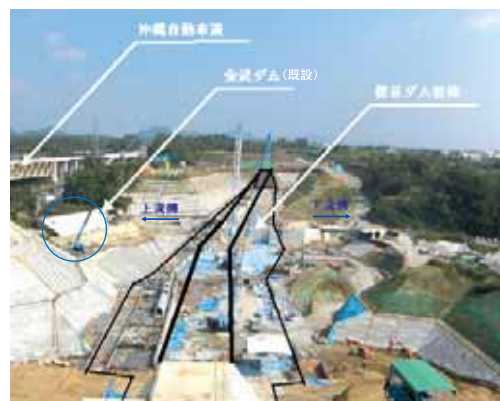
写真-3 億首ダム工事状況（全景）
