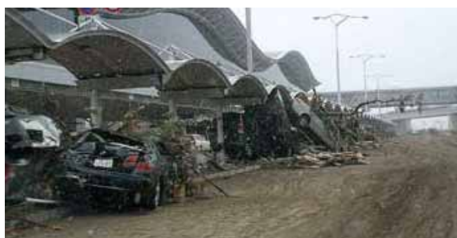
仙台空港(JR空港駅)の被災状況
