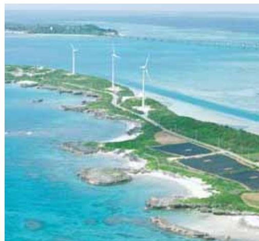
狩俣風力発電設備（沖縄電力（株））
