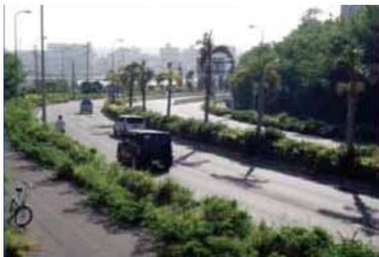
供用後 国道331号泊向け
