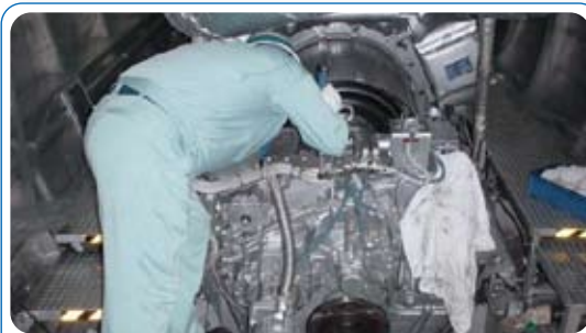
主機関検査の様子
