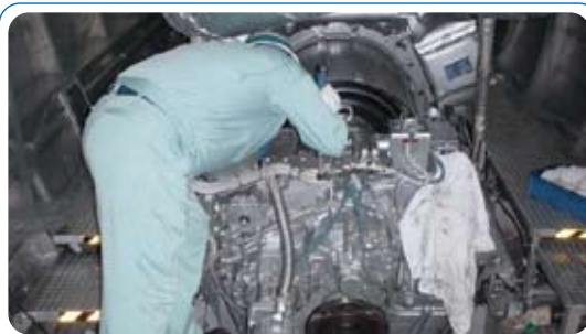
主機関検査の様子
