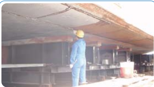
船体外板検査の様子
