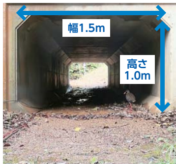
道路面から約1.5m下に設置 高さ:約1.0m/幅:約1.5m/延長:約12m
