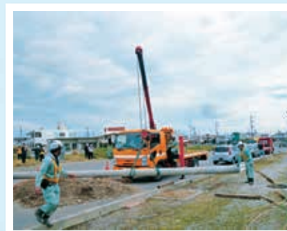
ユニックによる倒壊電柱移動訓練
