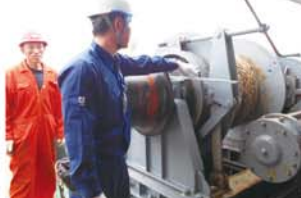
PSC実施中の様子（係船機）
