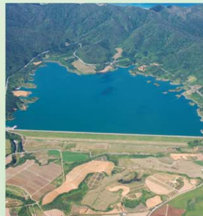
底原ダム(石垣市)
