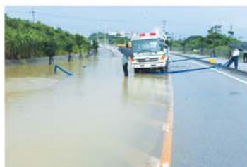
①排水ポンプ車
