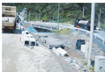
③応急組立橋
