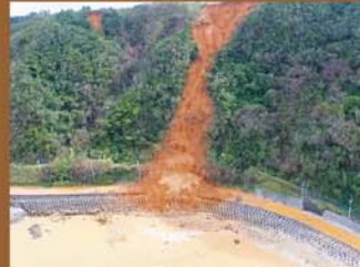
一般国道331号東村平良地区
