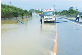
①排水ポンプ車
