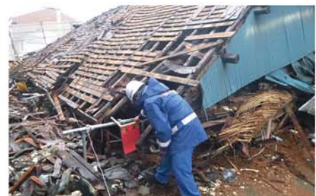
被災状況調査班(建築物判定)の様子 (応急危険度判定)
