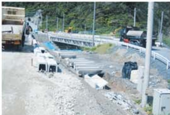
③応急組立橋
