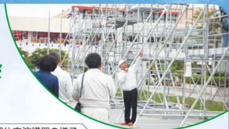
足場の組立・解体実演講習の様子
