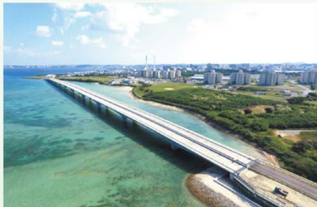
那覇港浦添ふ頭地区臨港道路工事状況
