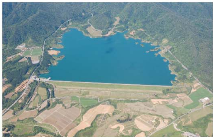
底原ダム(石垣市)
