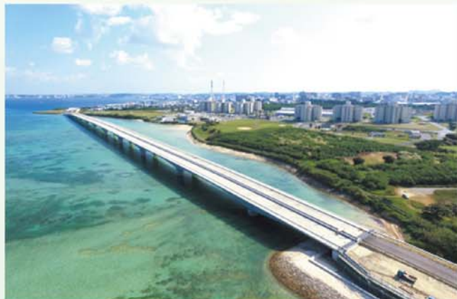
那覇港浦添ふ頭地区臨港道路工事状況
