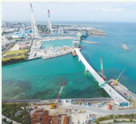
浦添北道路（牧港高架橋）工事状況
